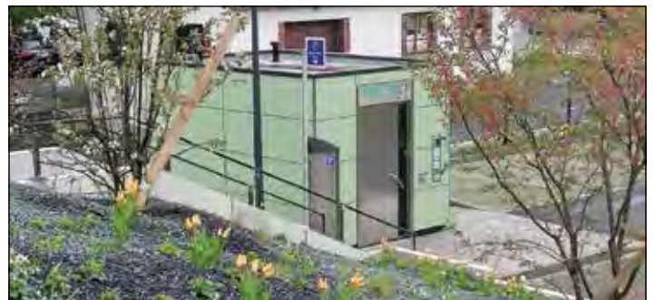
Die neue Toilettenanlage am Bürgerteich Foto: Stadtverwaltung Schleiz
